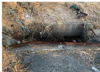
津波の被害 (フェンスの柱が曲がったまま残されている)
