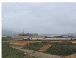
⑦岩井崎の現在の街/地震によって沈下した地盤を高くする作業をしている
