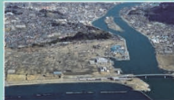
(日和山下方が被害の大きかった沿岸部、上方が内陸部)
