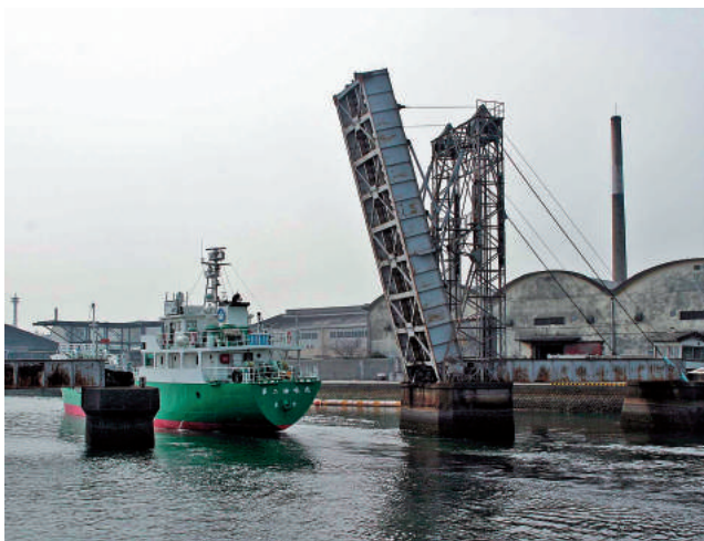
写真8: 鉄道跳開橋「末広橋」 (1931年完成、JR貨物四日市港線として使用、2008年3月筆者撮影)
