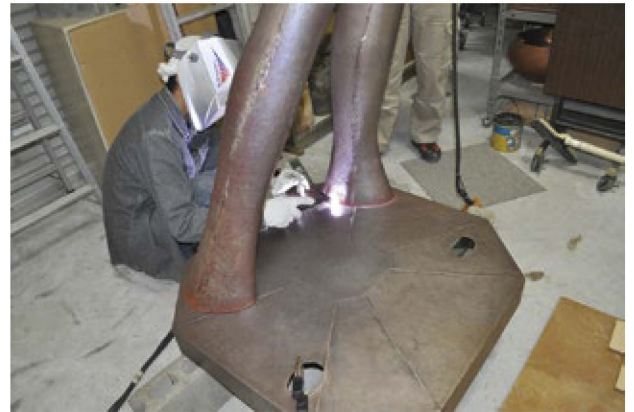
写真22:脚部を台座に溶接する
