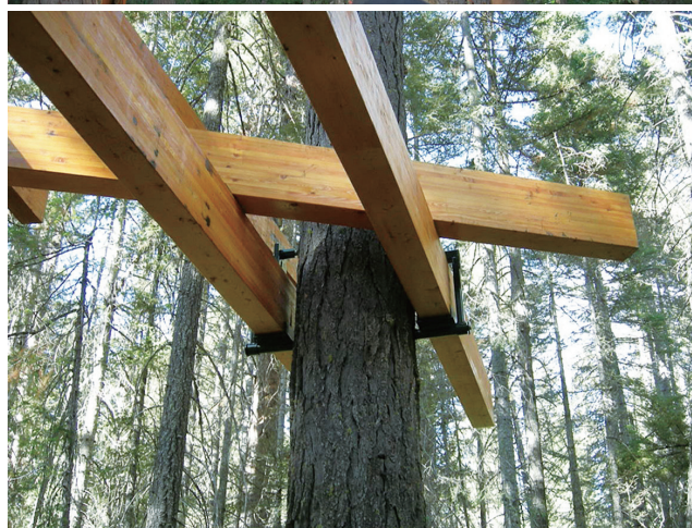
写真6,7,8: GLと様々な受金具を使った施工[6]
