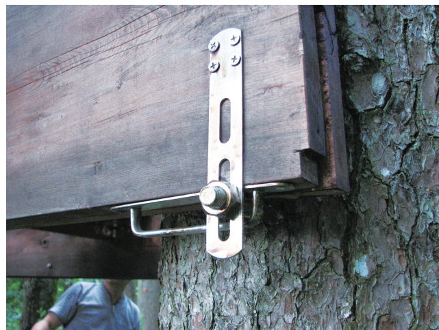
写真12: 二次試作において幹に打ち込んだボルトに木材を取り付けた部分
