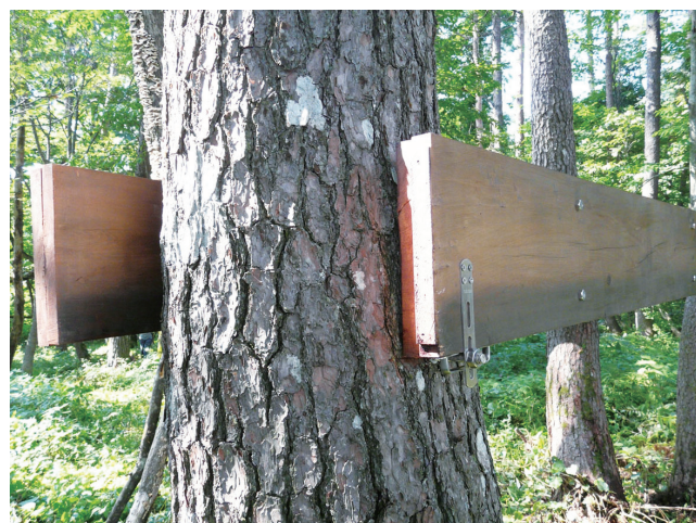
写真13: 南側直径40cmの樹木の幹の両側に取り付けられた構造部材
