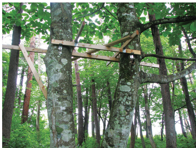
写真9: 一次試作／トチの木のうえに取り付けられた床のベース／西側より見上げる
