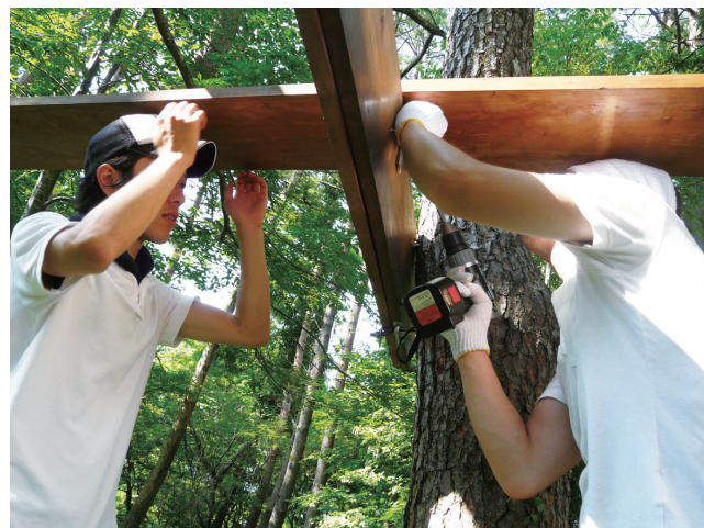
写真14: 2枚の構造部材を連結する
