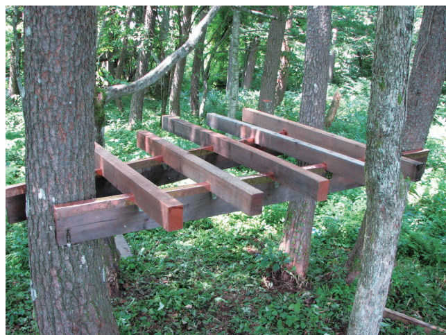
写真15: 二次試作／根太が完成した状態
