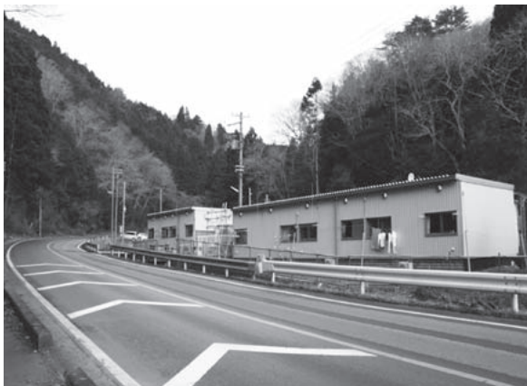
写真5 仮設家ノ入団地(総数15戸程度の小さな仮設団地)
