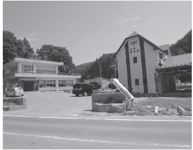
写真 2d 荻浜地区（左側の建物は石巻市役所荻浜支所、建物1階部分は天井まで津波により浸水）
