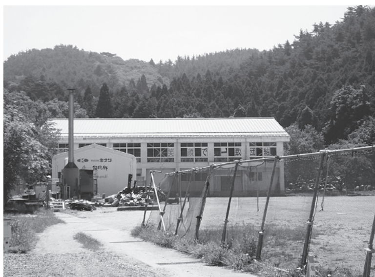
写真8 入浴施設（体育館前の建物が入浴施設）
