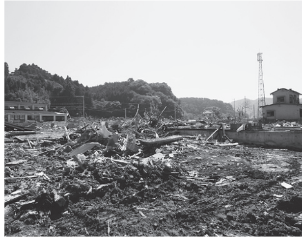
写真 2b 荻浜地区（住居が並んでいた場所、基礎のみが残る。右端の建物は残ったが、住居内は津波によって大きな被害を受けている）
