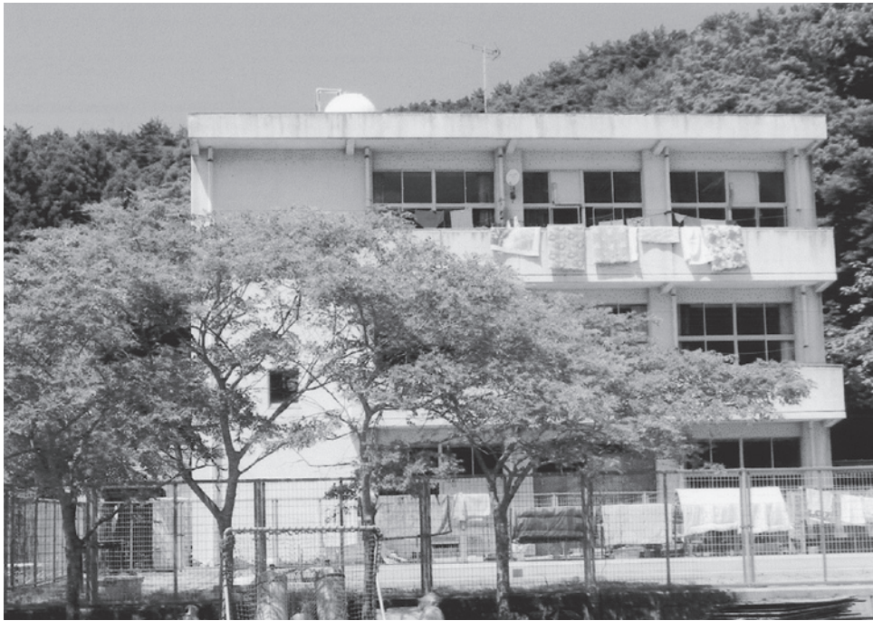
写真4 荻浜中学校新校舎（全て避難者居室）
